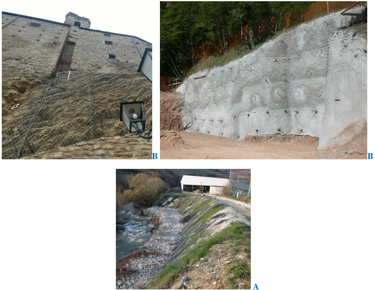
Figura 7 ESEMPIO TIPOLOGICO DI RETE PARAMASSI CON SPRITZ BETON (intervento A e B)
